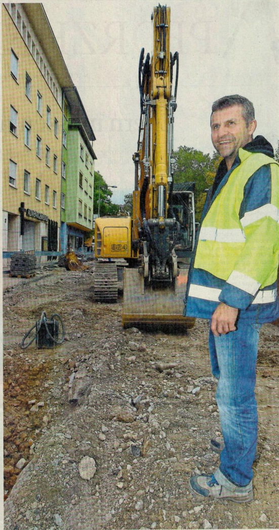
Hier lauert die nächste kritische Stelle: Unter die östliche Seite der Jahnstraße, zwischen Bleich- und Weierstraße, kommt ein Kanal. Bauleiter Johannes Baur denkt von Abschnitt zu Abschnitt.
