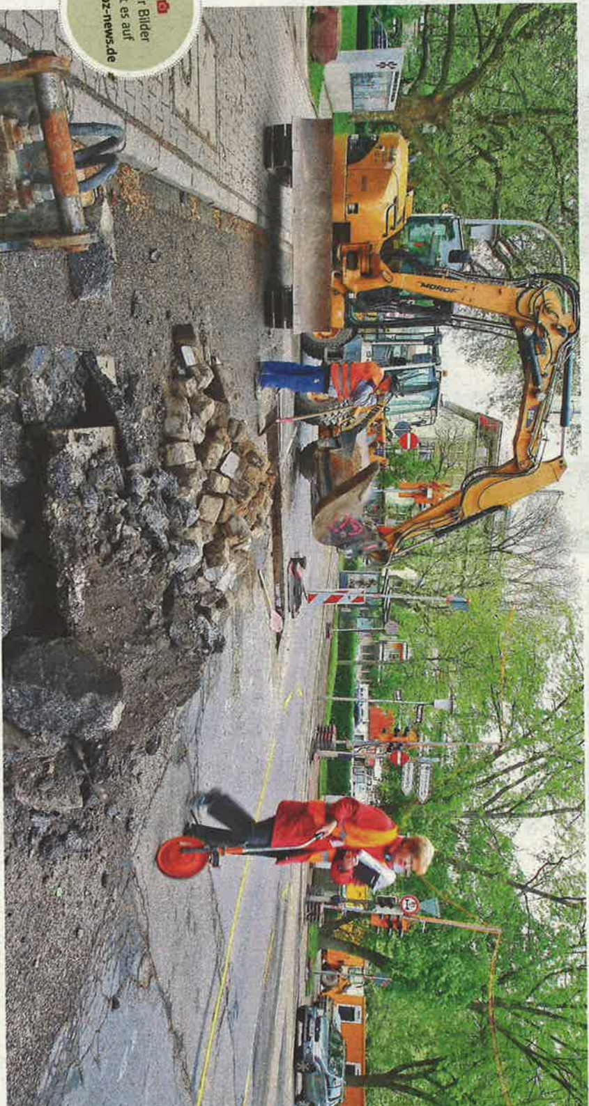
Ausmessen und aufgraben läuft vor dem Schmuckmuseum parallel: Erste Asphaltbrocken sind auf der Jahnstraße weggespitzt.
