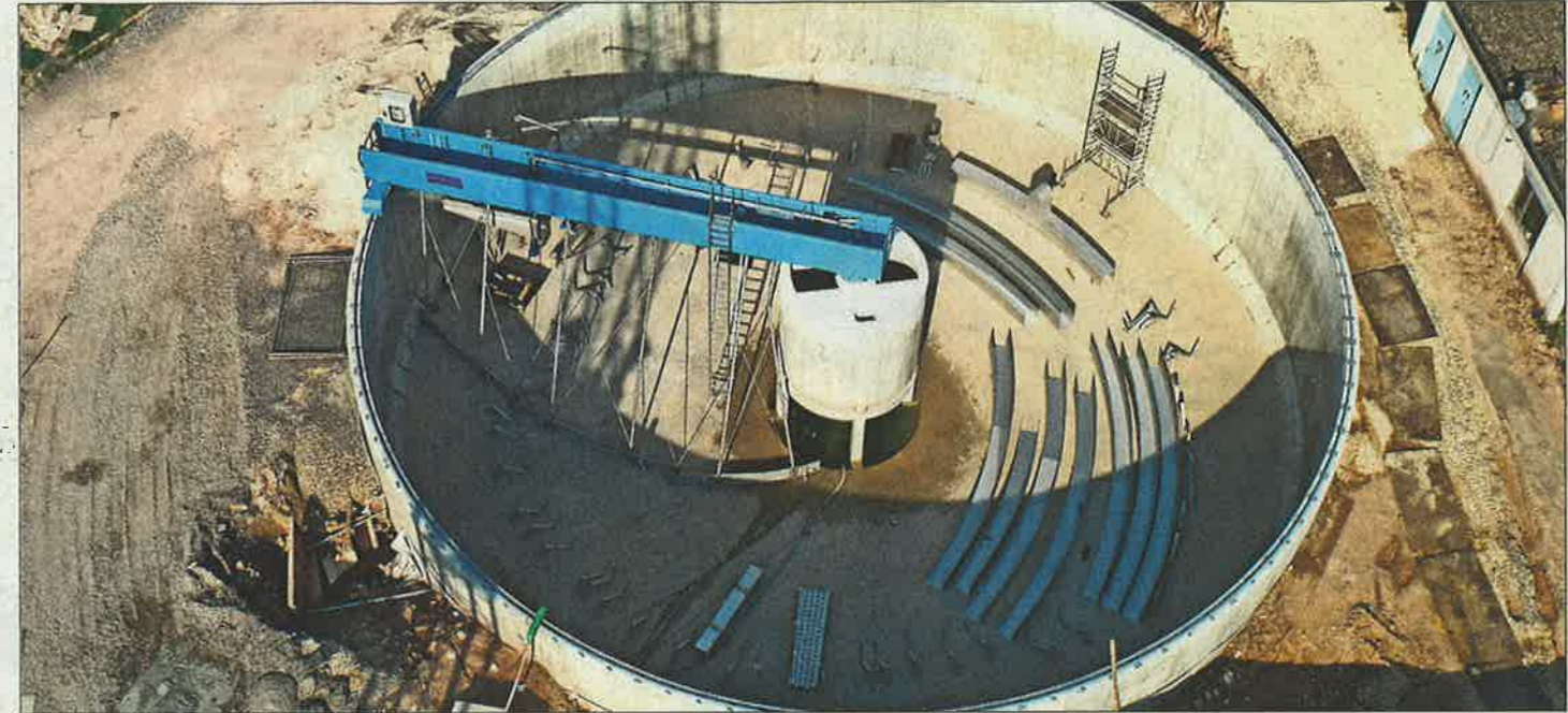
Beeindruckend groß: das neue Nachklärbecken (vom Kran aus fotografiert) fasst 2600 Kubikmeter Wasser.
