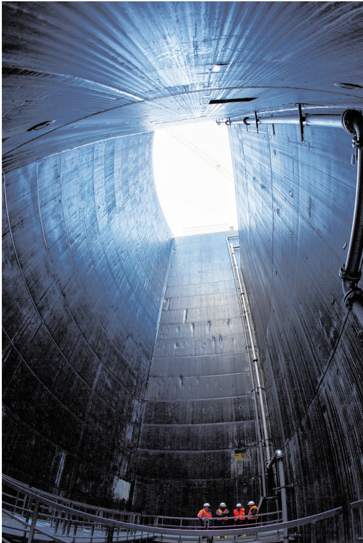
Schwarzer Schacht, fast 40 Meter tief: Das neue Pumpwerk der Emscher Genossenschaft auf dem Gelände des Klärwerks an der Welheimer Mark soll das Abwasser des neuen Emscherkanals aufnehmen.
