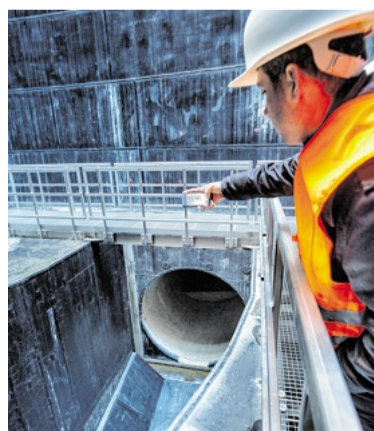
Das Loch des Emscherkanals, 2,80 Meter im Durchmesser, noch trocken.
