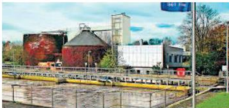
Das Gruppenklärwerk in Wendlingen wird um eine Reinigungsstufe erweitert.
