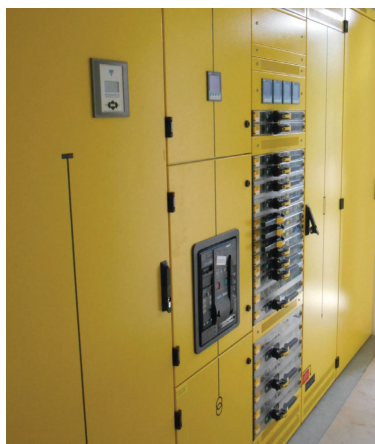
Niederspannungshauptverteilung
