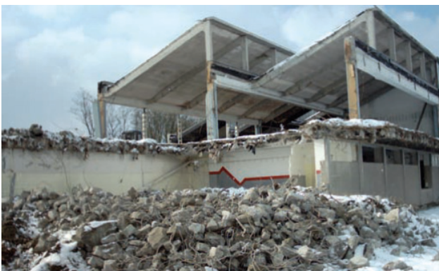
Gebäude-Audit, Rückbaukonzept, Asbestsanierung, Altlastenmanagement und Geotechnik für Gründung und Neubau
