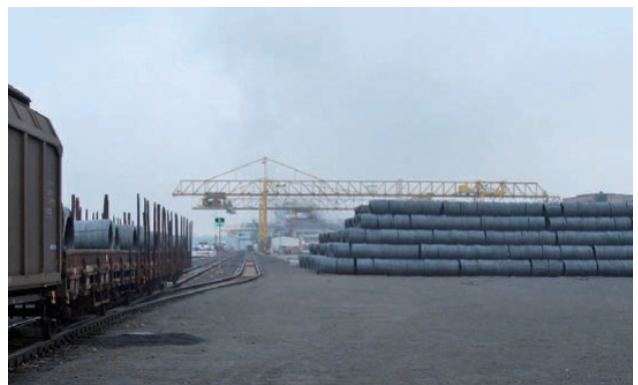
Planung und Bau einer Werkstraße für extremen Schwerlastverkehr
