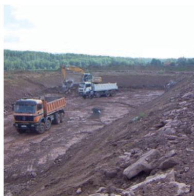
Bau eines Versickerungsbeckens
