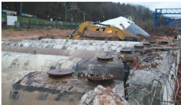
Erkundungsarbeiten in beengten Verhältnissen und im Freigelände
