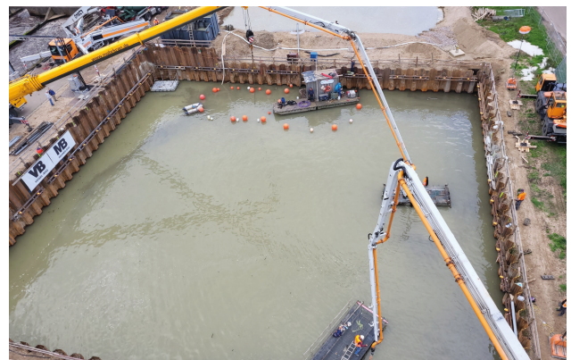
Herstellung Unterwasserbetonsole in Spundwandbaugrube
