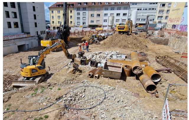
Herstell- und Aushubarbeiten, Baugrube NB Ebersteinstraße PF
