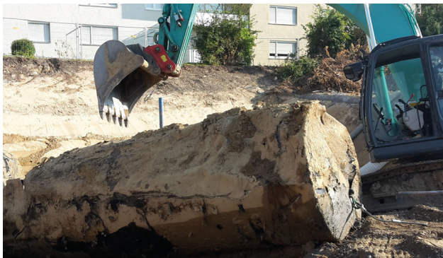
Ausbau eines Heizöllagertanks
