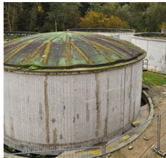
Zwischenstand Fräsarbeiten PCB-Sanierung und Kernbohrungen Asbestsanierung
