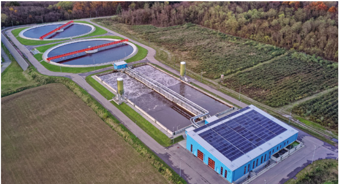
Luftbildaufnahme mit zwei Nachklärbecken, Belebungsbecken und Betriebsgebäude mit Photovoltaikanlage (Quelle: AZV Breisgauer Bucht)
