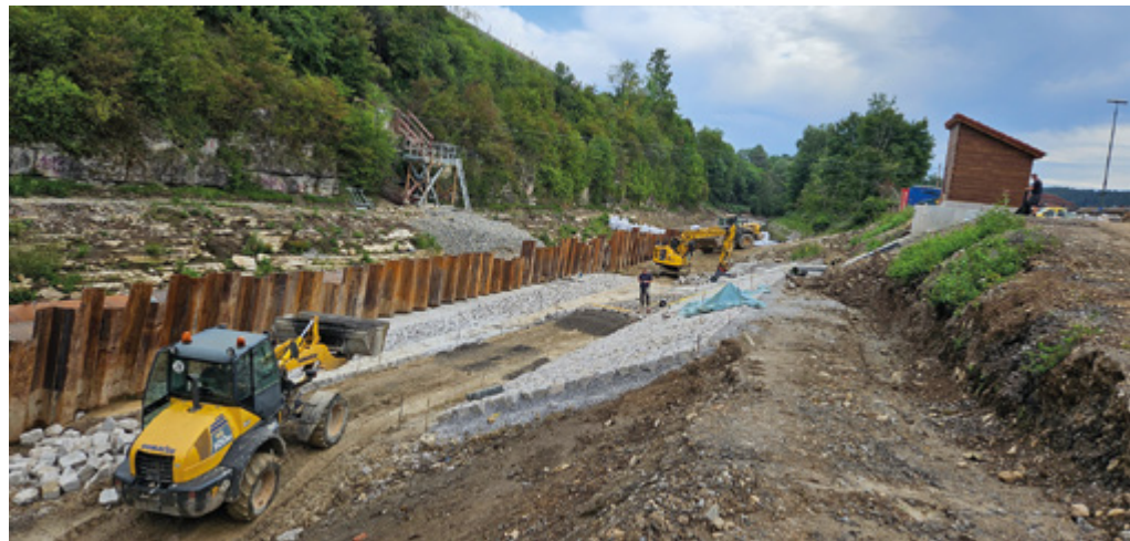
Blick auf das neue Pegelhaus mit Seilkrananlage und im Bau befindliches Einschnürungsbauwerk
