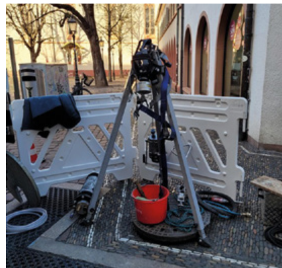
Arbeitssicherheit bei der grabenlosen Kanalsanierung
