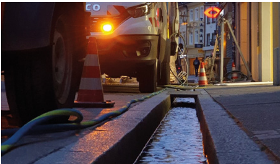
Linereinbau unter erschwerten Platzverhältnissen – die „Freiburger Bächle“
