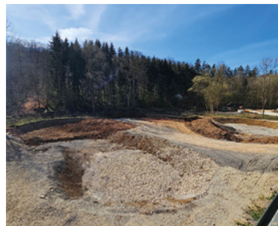
Zustand nach Rückbau
