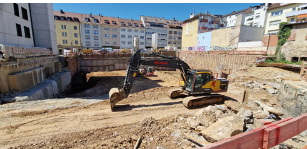
Impression Verbau- und Erdarbeiten, Stand 8. August 2025
