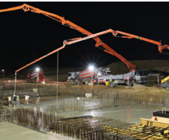
Betonage Bodenplatte Belebungsbecken (Quelle: HOLINGER-Ingenieure)
