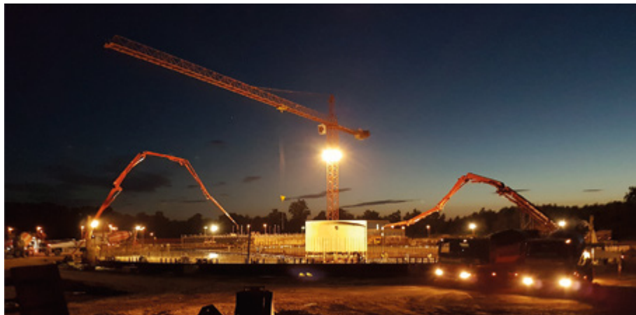
Betonage Bodenplatte Nachklärbecken (Quelle: HOLINGER-Ingenieure)
