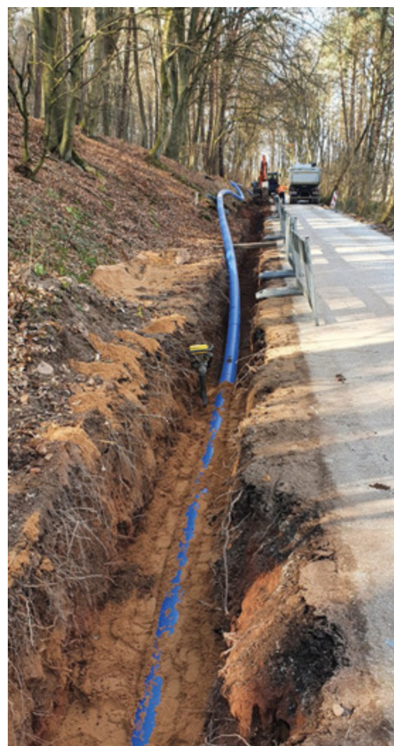
Trinkwassertransportleitung
