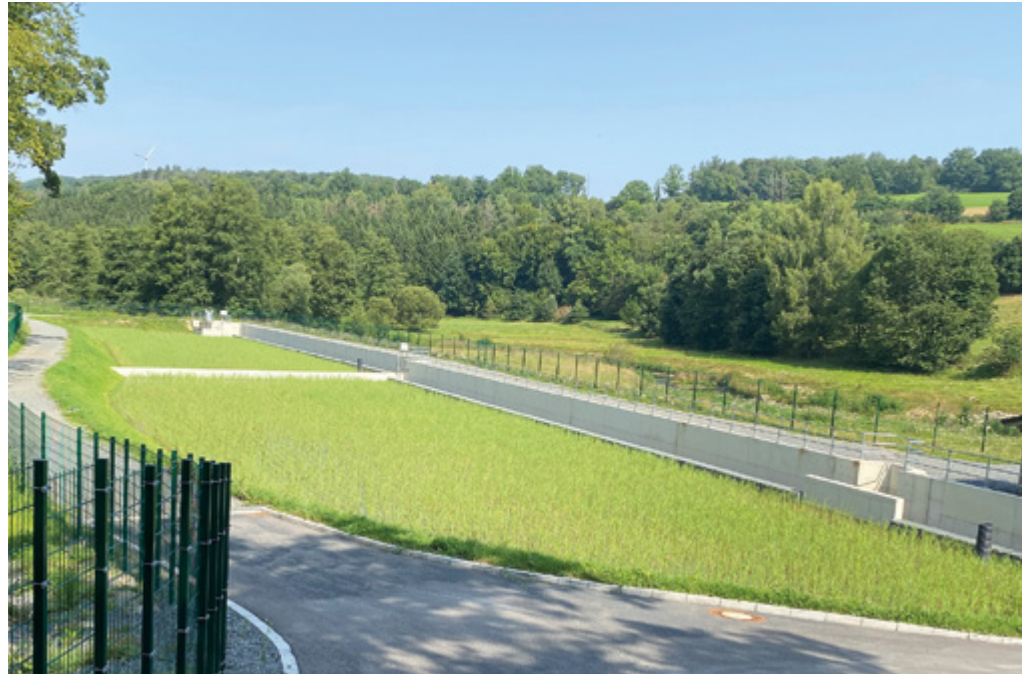
Retentionsbodenfilter zur nachhaltigen Reinigung des Mischwassers vor der Einleitung ins Gewässer (Foto: Rainer Bajog)
