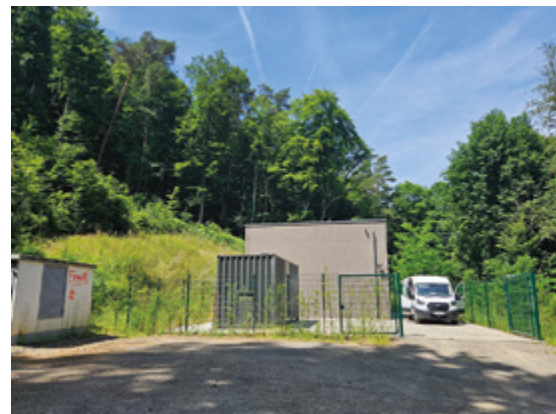
Wasserwerk Erlenbach Außenansicht
