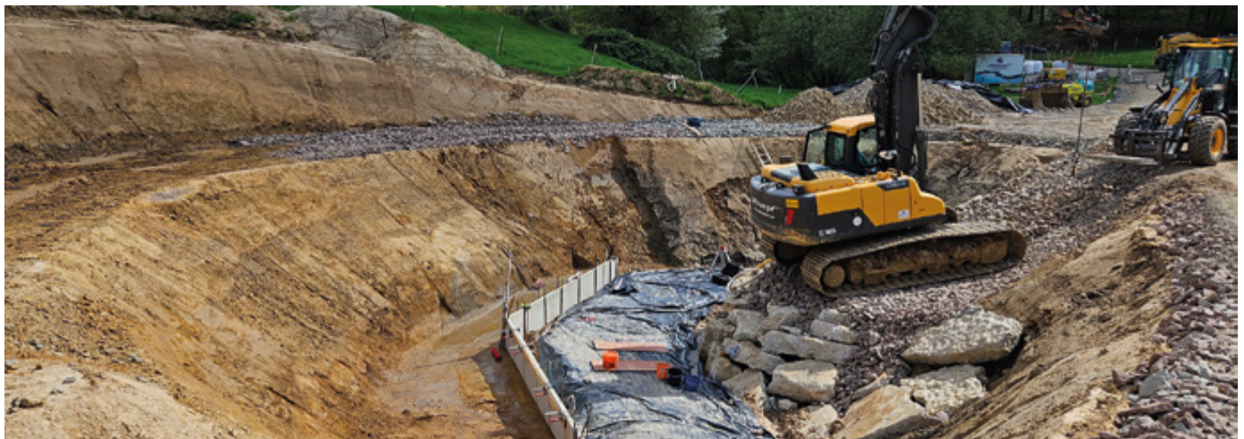
Freigelegte Quelfassung: Stellung der neuen Staumauer
