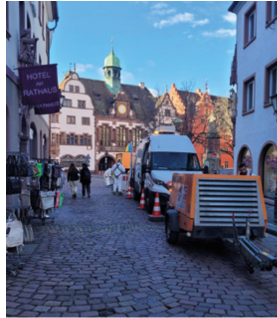
Vorarbeiten Schlauchlinereinbau Fußgängerzone in der Freiburger Innenstadt – Rathausgasse
