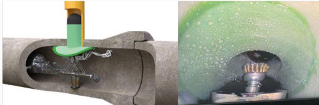
Hutprofilverfahren (Quelle: Pipetronics)
