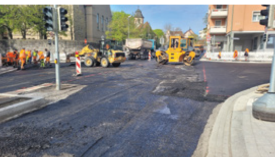
Einbau des lärmindernden Fahrbahnbelags
