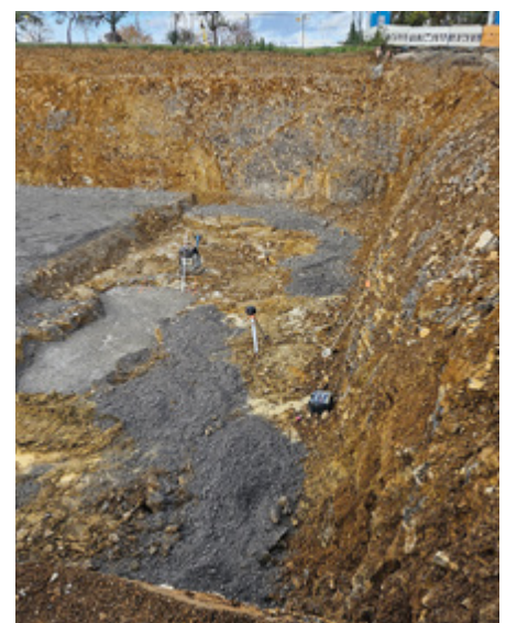
Vollständig ausgehobene Baugrube mit in Teilen eingebauter Sohlrandschicht sowie Verfüllung von Mehrausbrüchen durch massige Kalksteinbänke in der Gründungssohle
