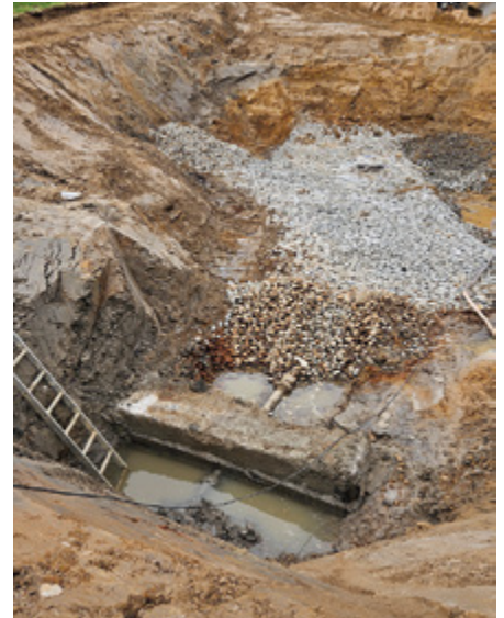
Alte, kolmatisierte Quelfassung
