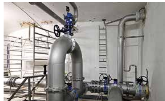
Erneuerung Rohrinstallation Rohrkeller
