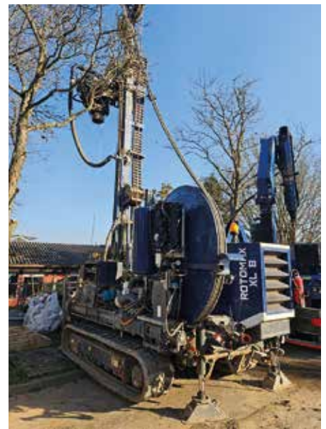
Brunnenbohrarbeiten für die Förderbrunnen
