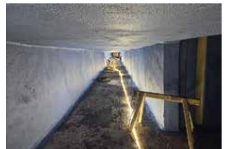
Flächen mit fertiger XBSK-Beschichtung
