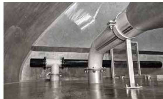
Edelstahl-Einbauten Wasserkammer
