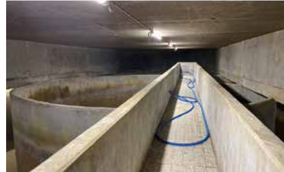
Bestand vor Sanierung
