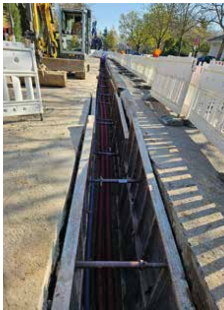
Rohrleitungsgrabenbau im Projektgebiet
