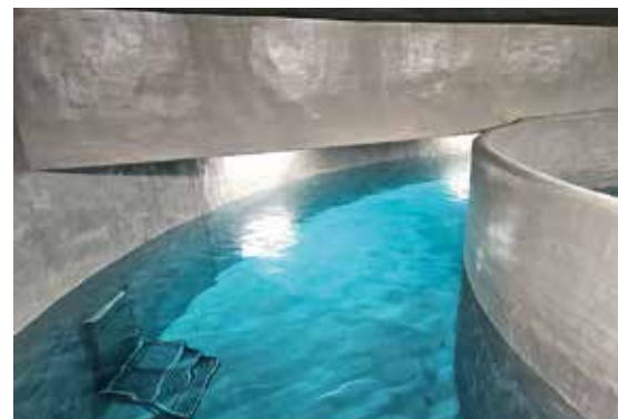
Innere Wasserkammer nach Sanierung
