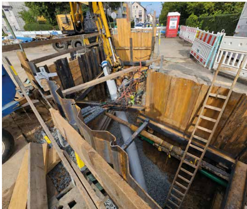
Baugrube auf engem Raum
