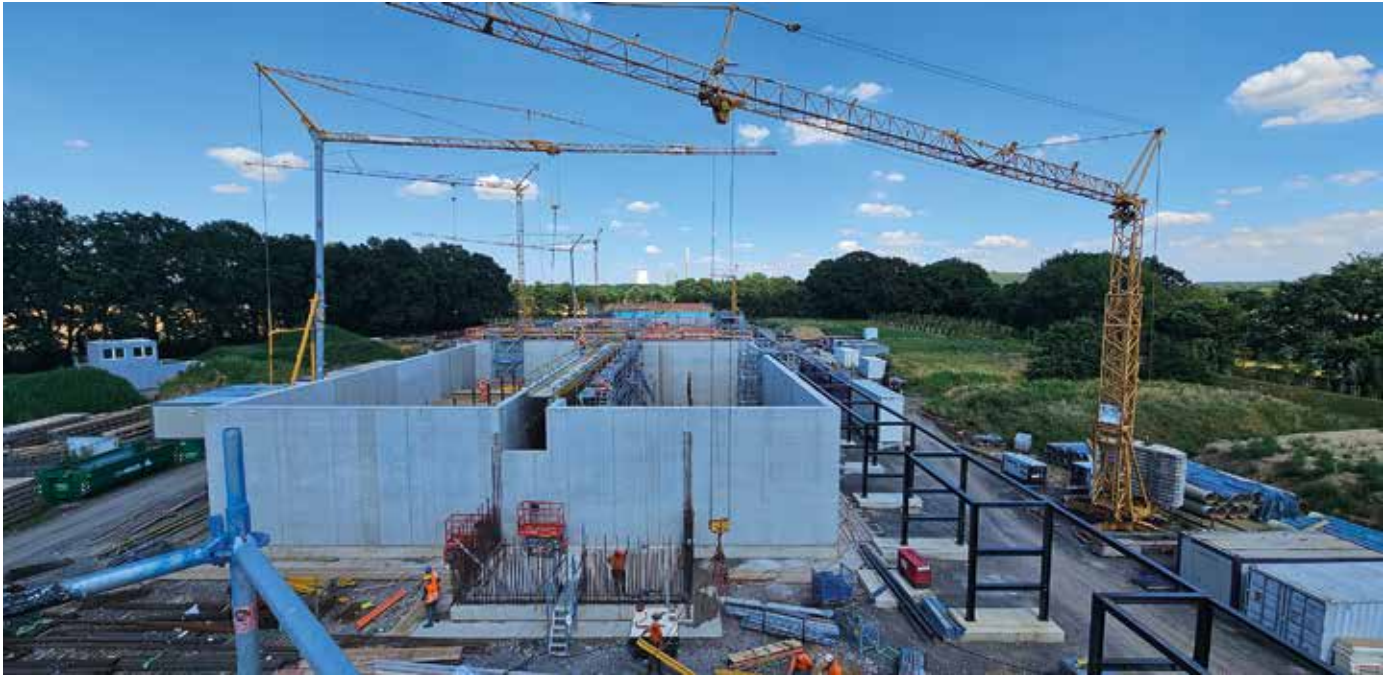
In Bau befindliche Linie 1 der AzGA Haus Aden
